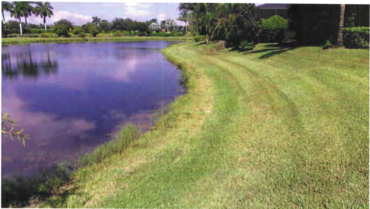
Lake Embankment - Lake #24
