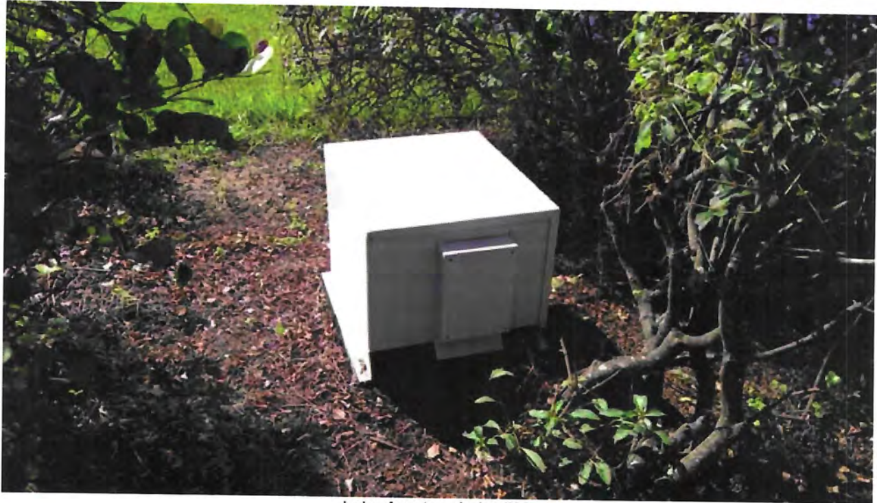
Lake Aerator - Lake #32
