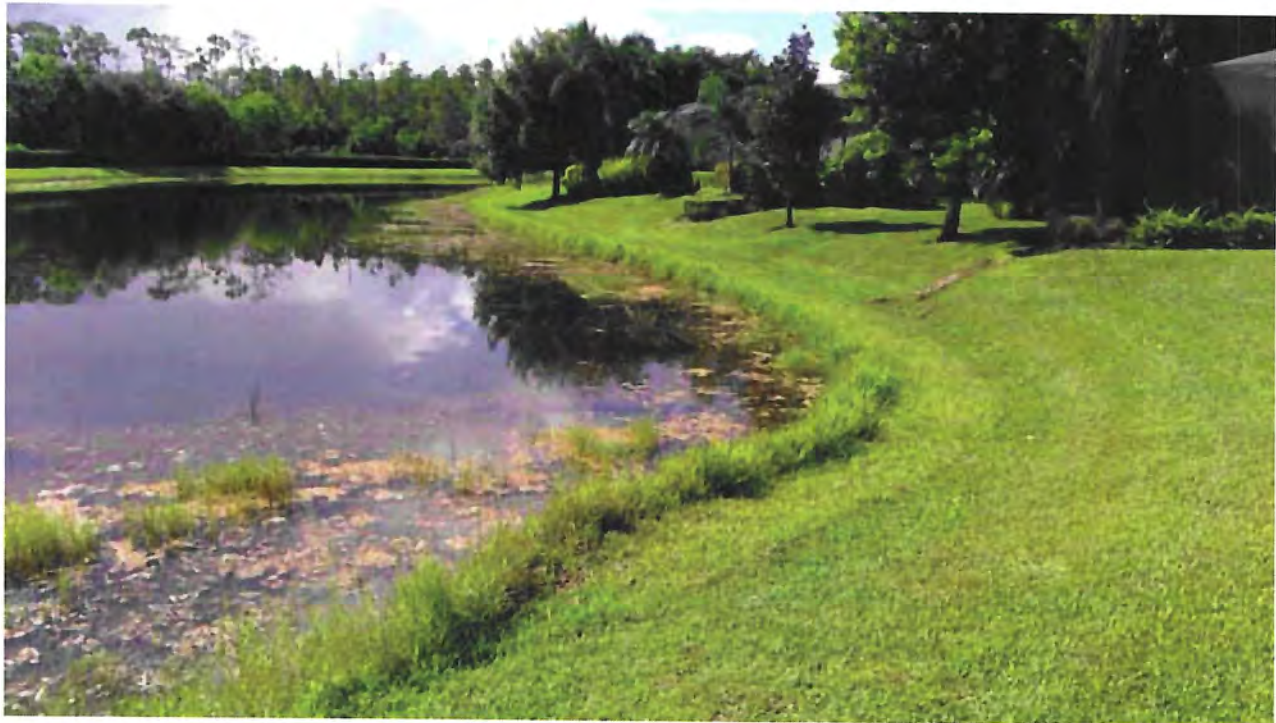
Lake Embankment - Lake #19
