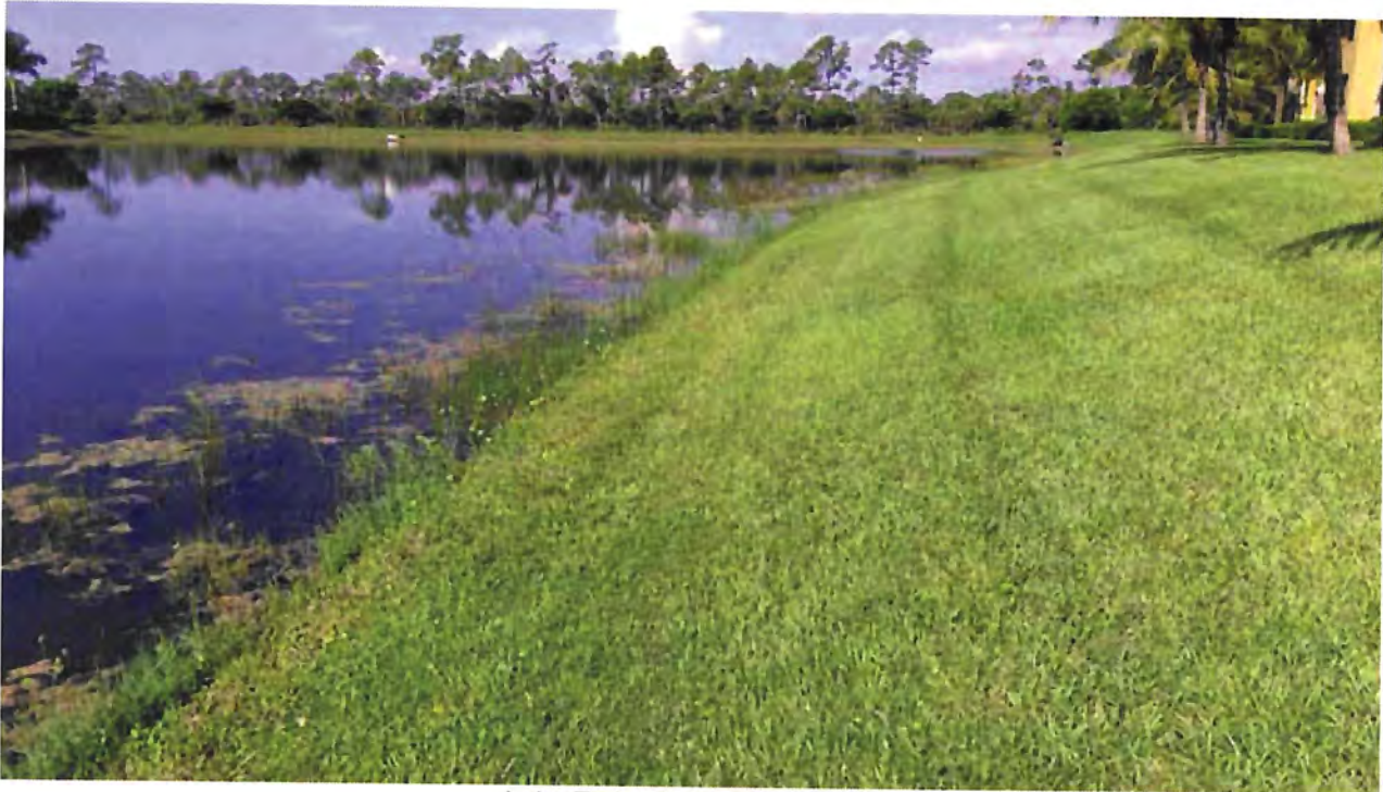
Lake Embankment - Lake #14
