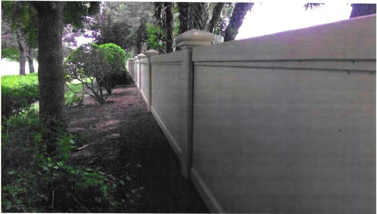
Site Wall - US 41
