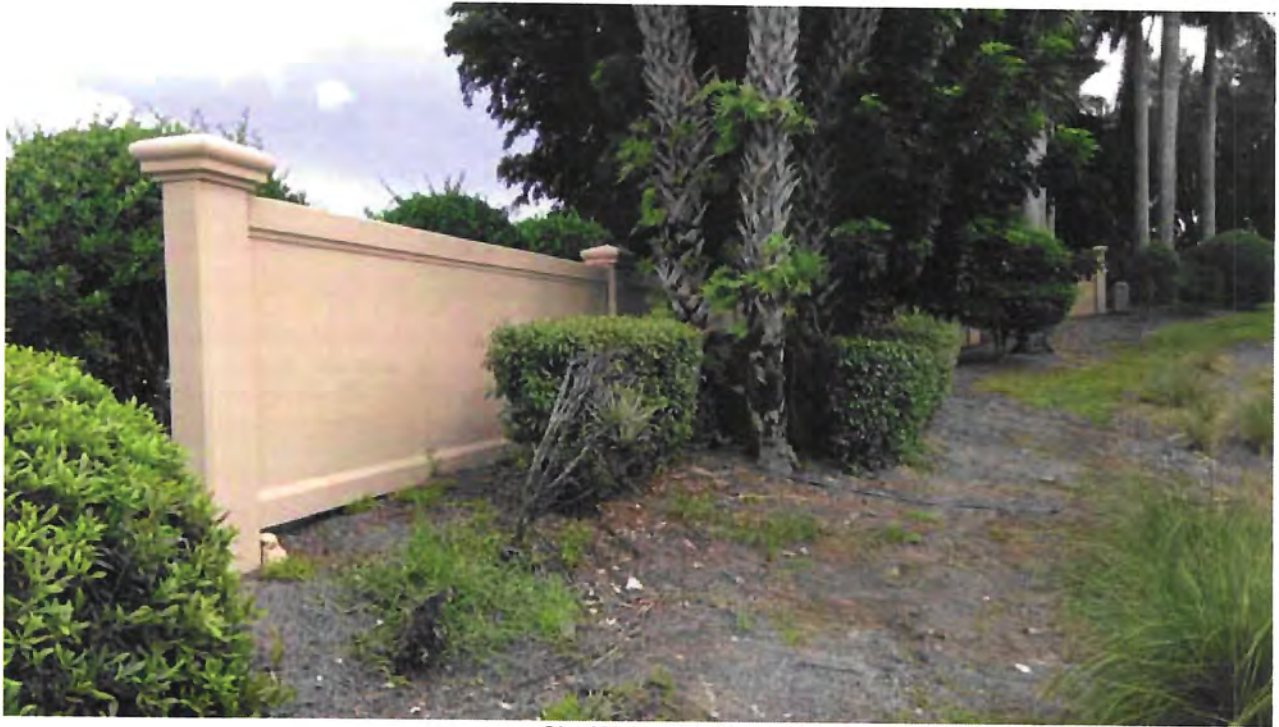
Site Wall - US 41
