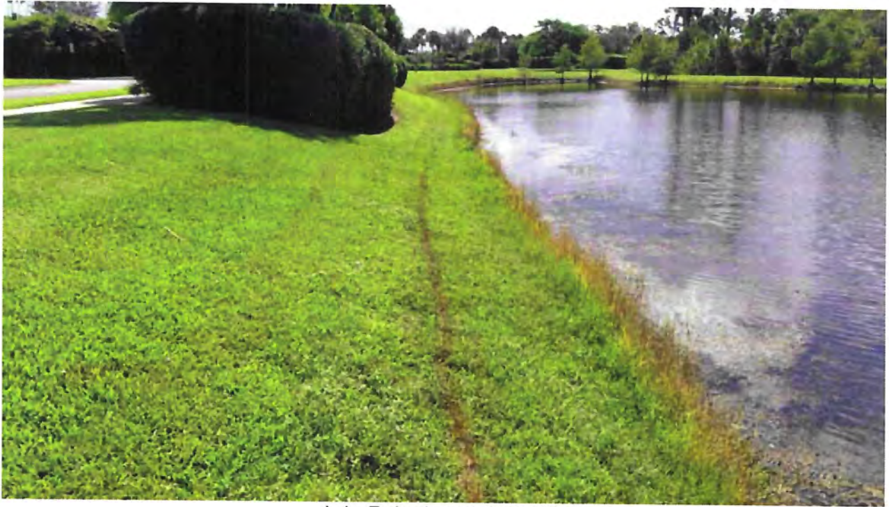
Lake Embankment - Lake #26
