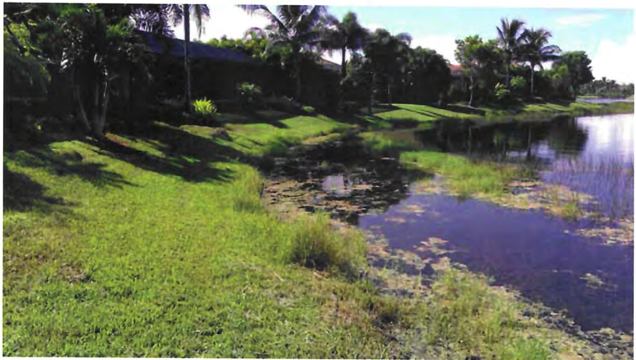
Lake Embankment - Lake #20
