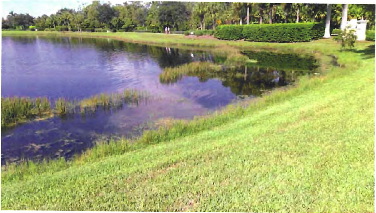
Lake Embankment - Lake #20
