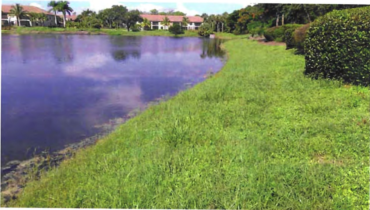
Lake Embankment - Lake #32
