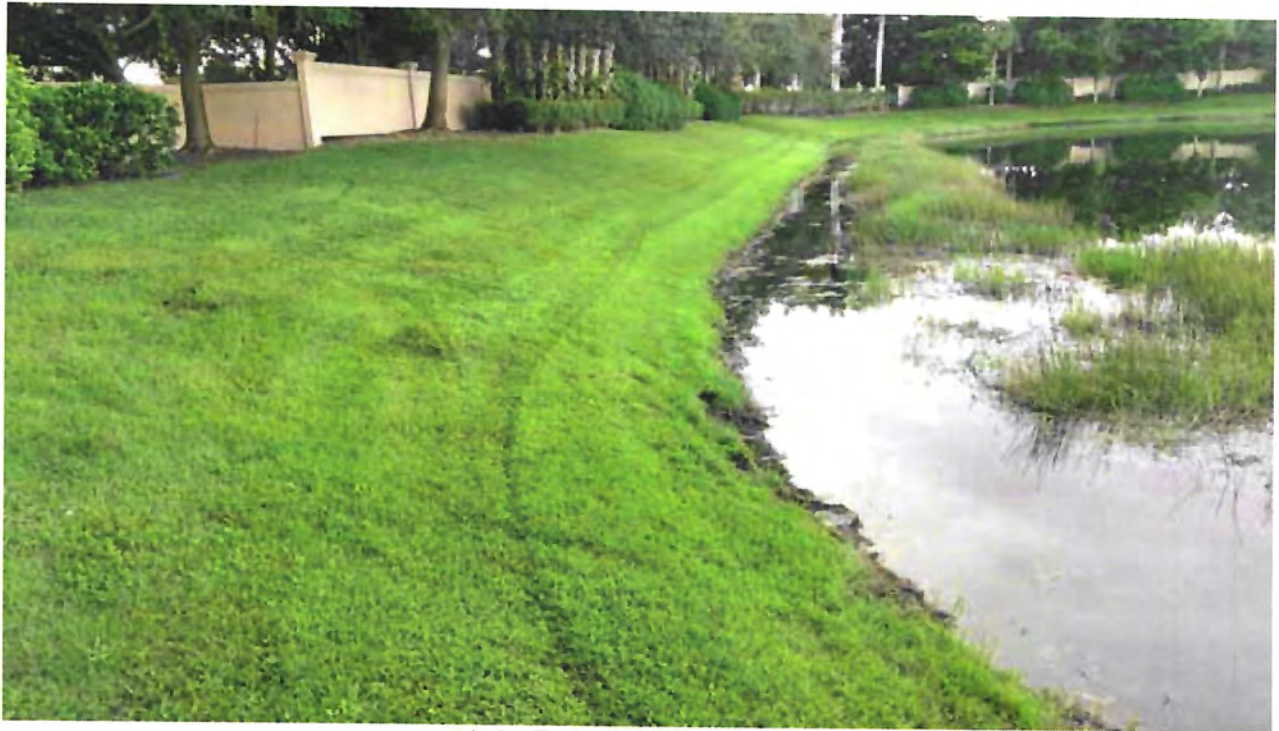
Lake Embankment - Lake # 5
