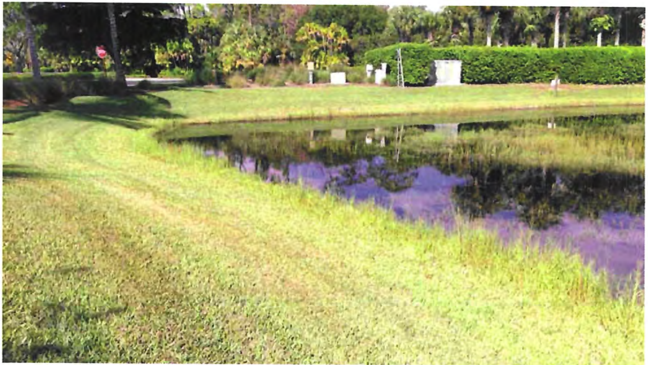
Lake Embankment - Lake #18
