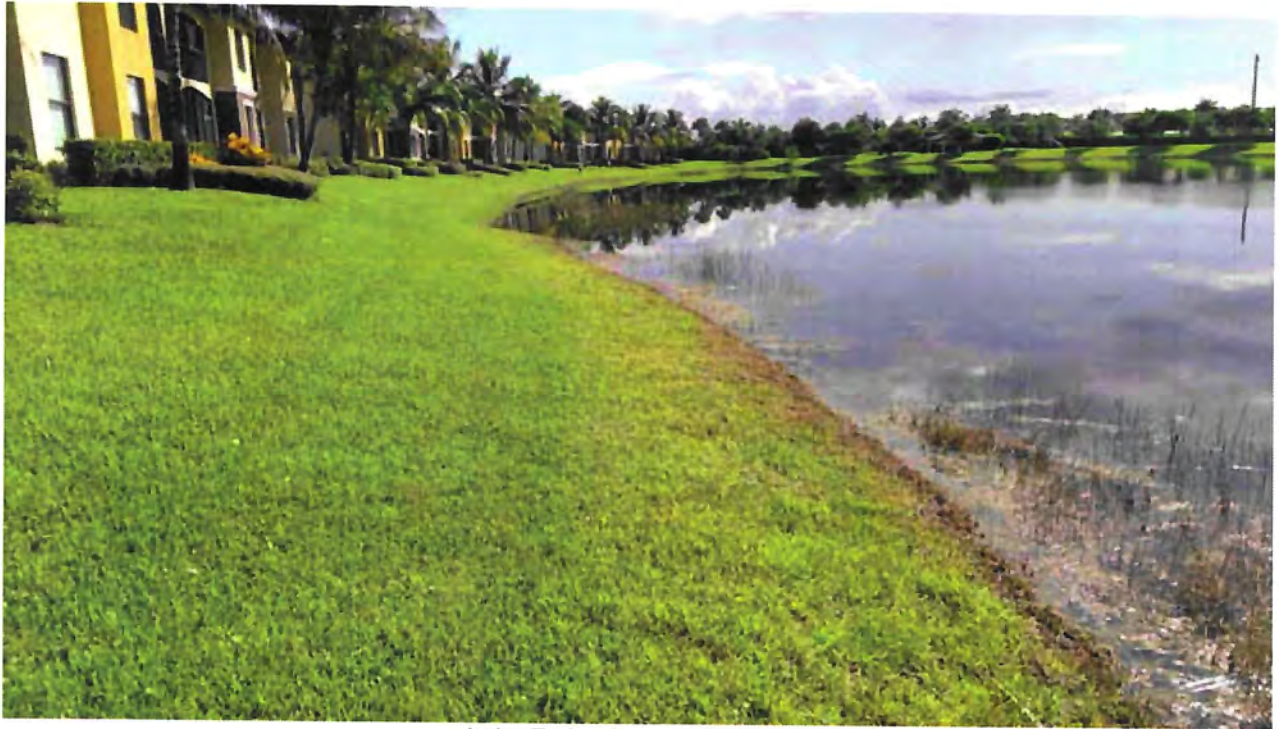
Lake Embankment - Lake #13
