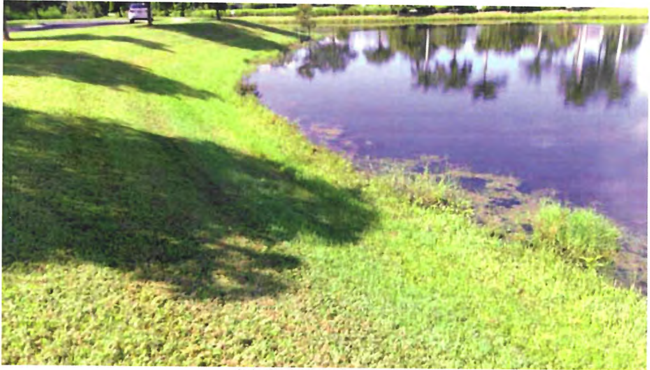
Lake Embankment - Lake #24
