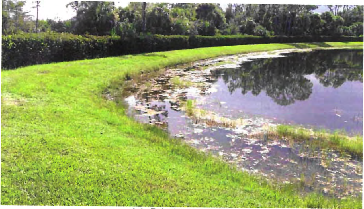
Lake Embankment - Lake #19
