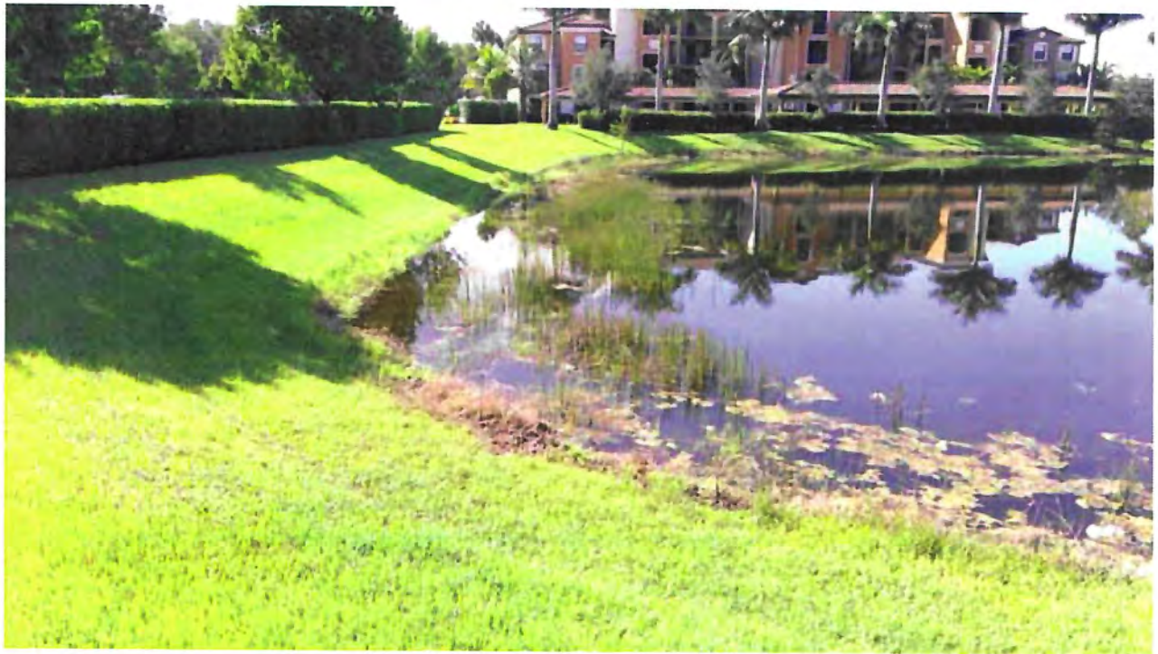
Lake Embankment - Lake #14
