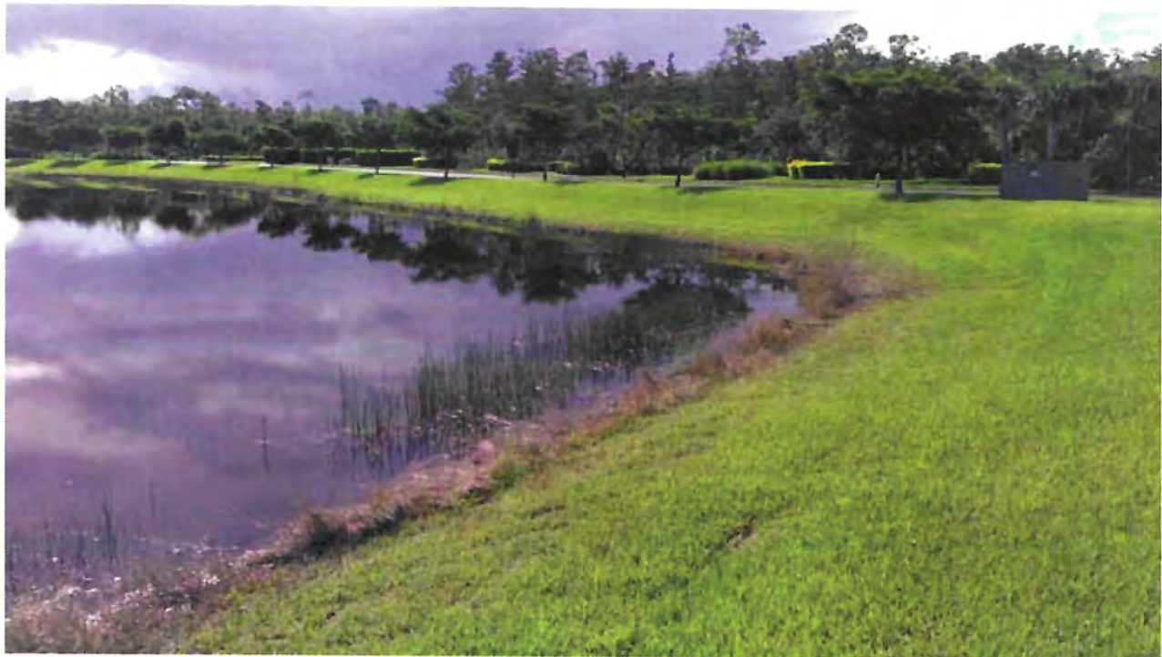
Lake Embankment - Lake #13
