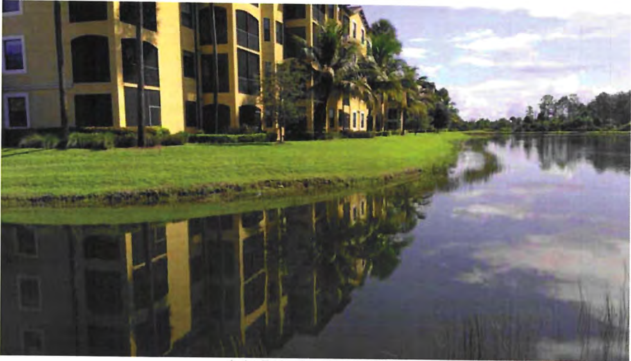
Lake Embankment - Lake #15
