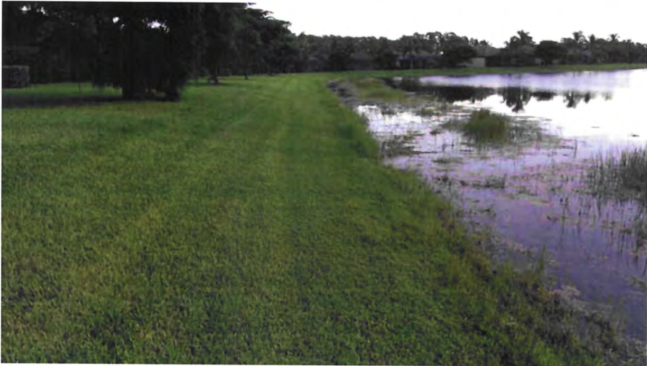
Lake Embankment - Lake # 9
