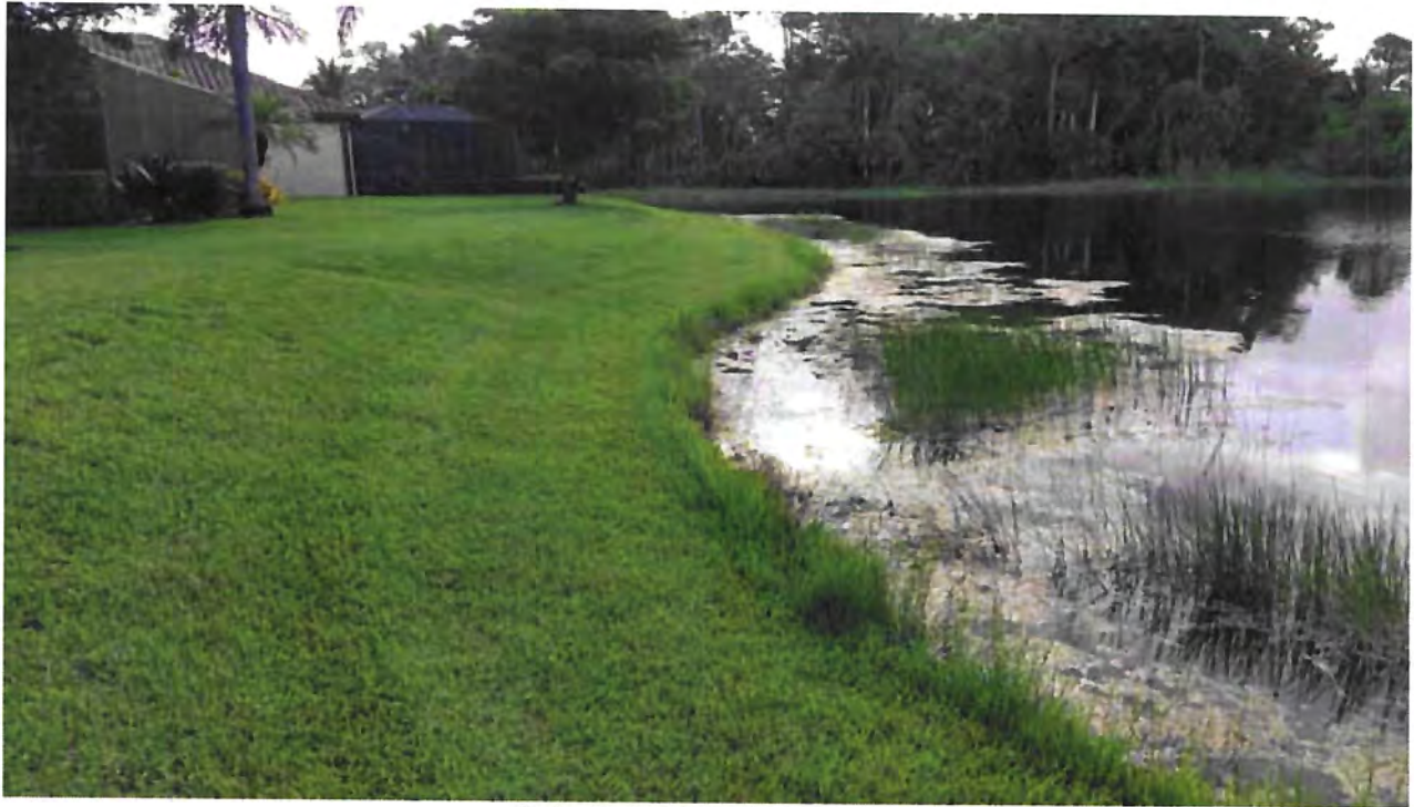
Lake Embankment - Lake # 9
