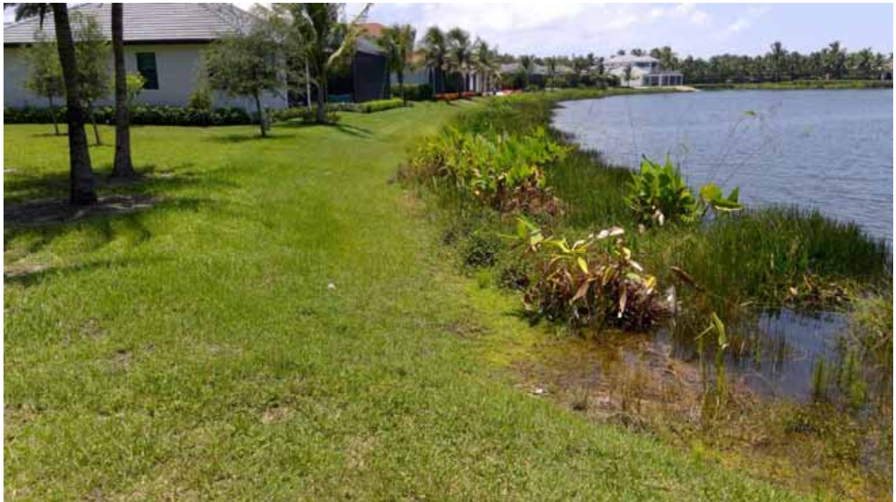
Lake Embankment - 1A
