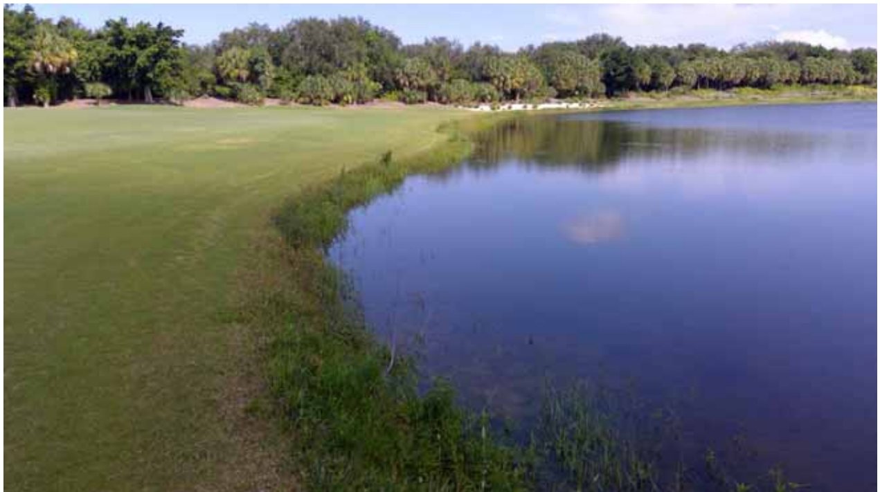
Lake Embankment - 6D
