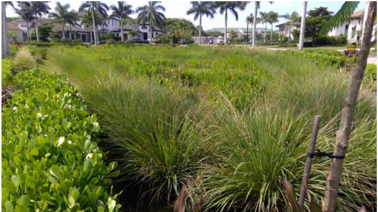
Dry Detention Area - Via Lugano
