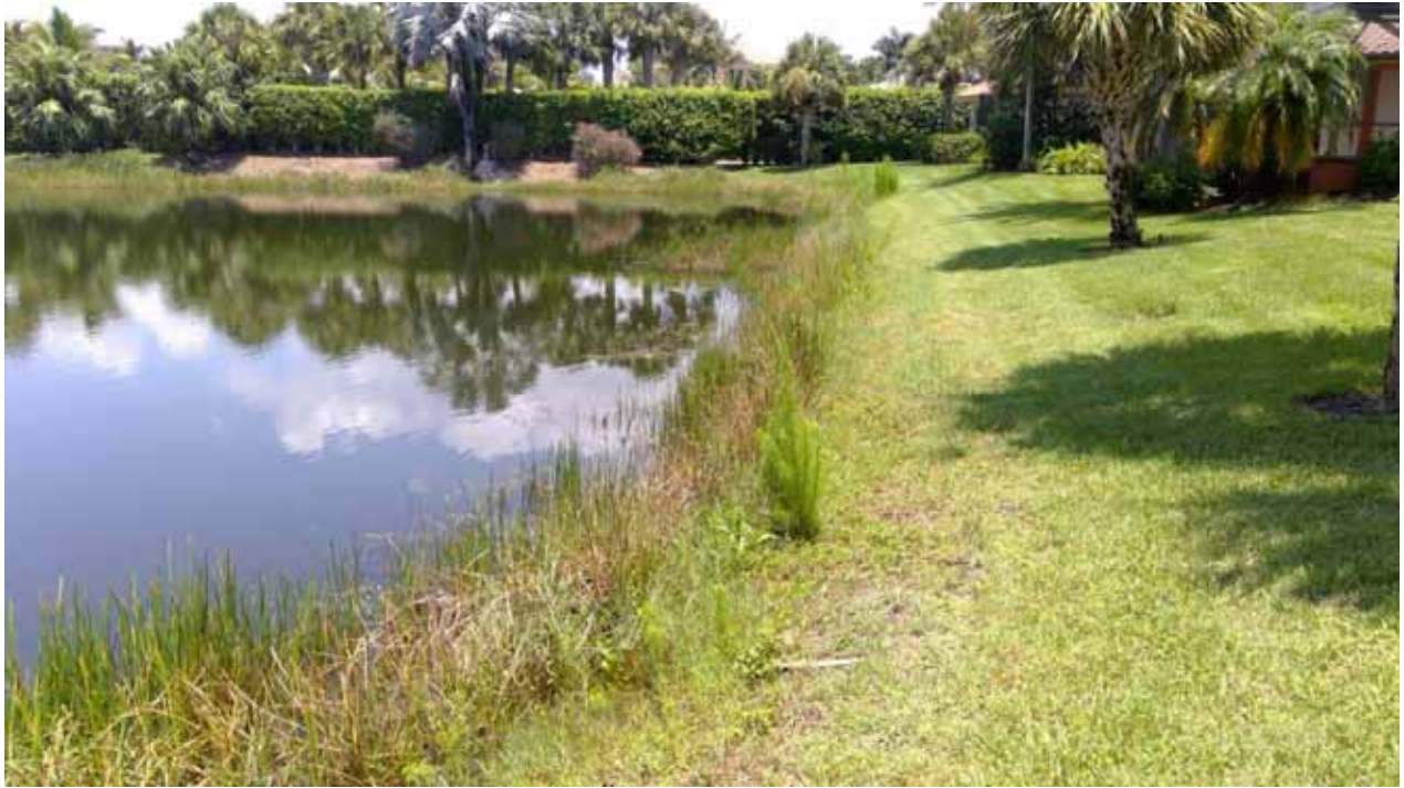
Lake Embankment - 6F
