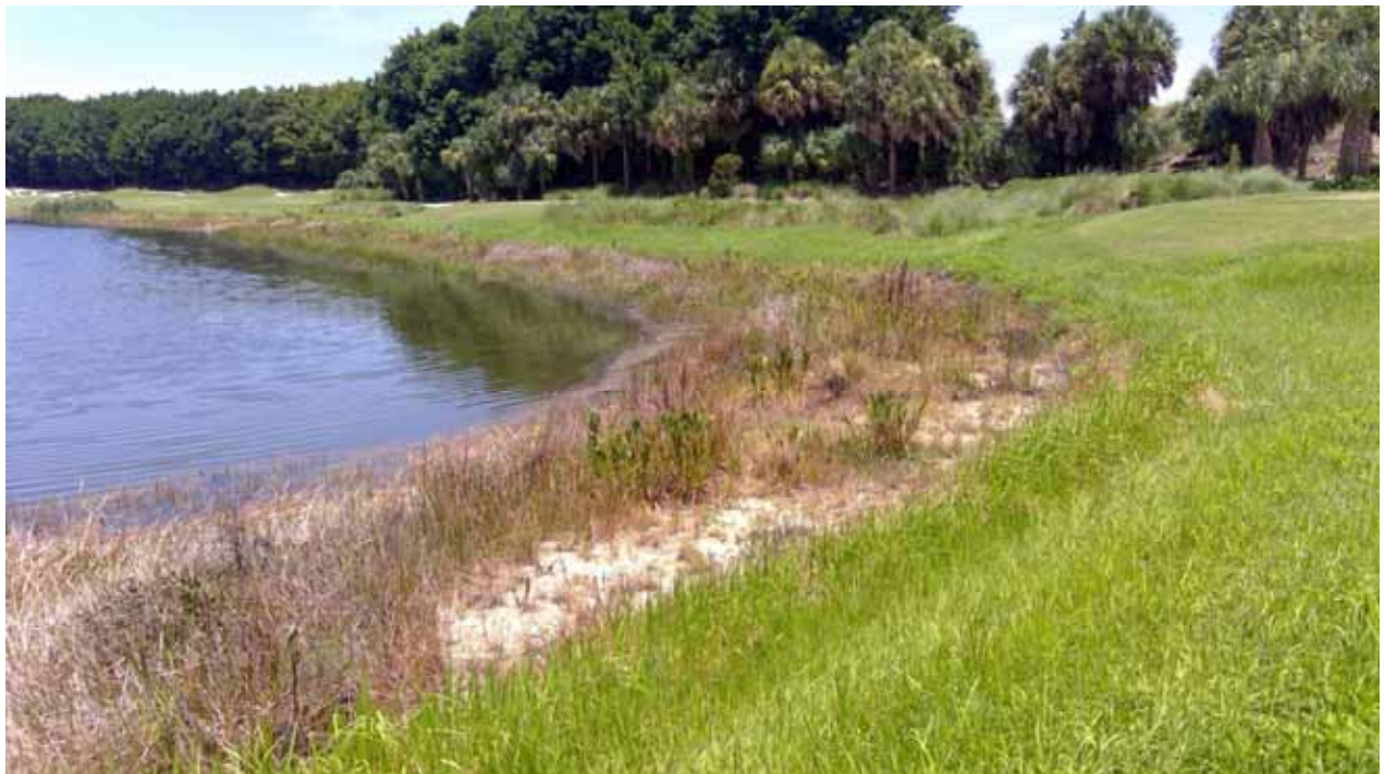
Lake Embankment - 1B
