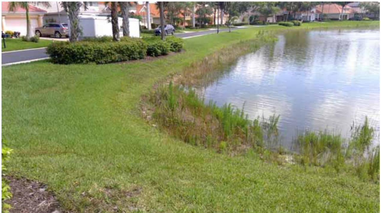
Lake Embankment - 3B
