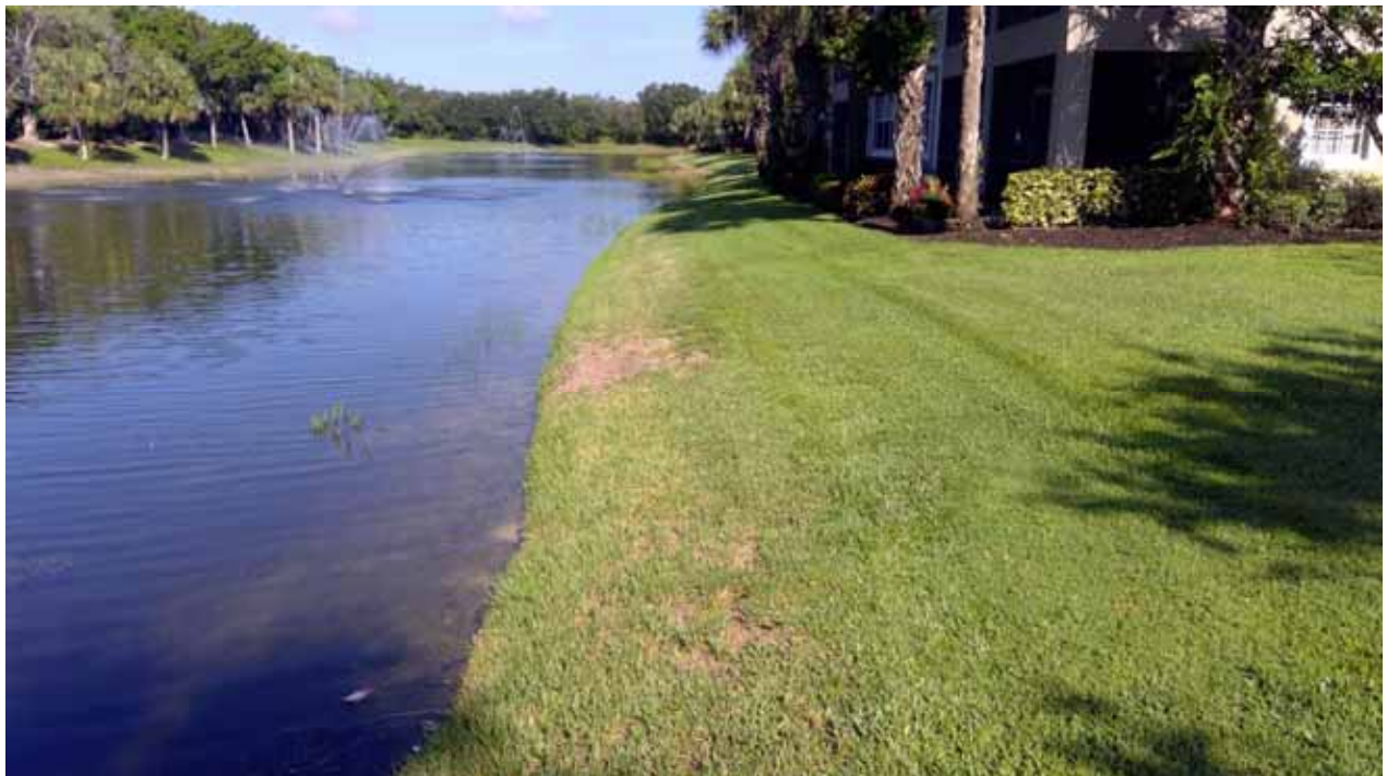
Lake Embankment - 6G
