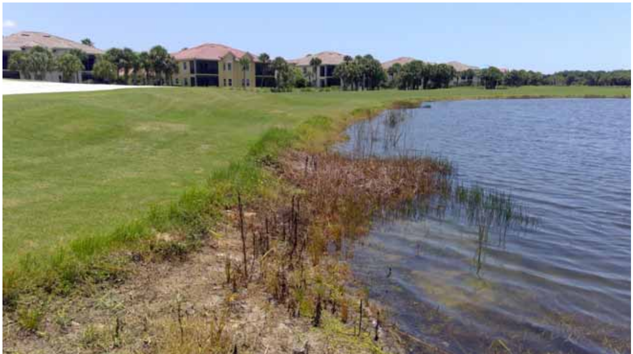
Lake Embankment - 6E
