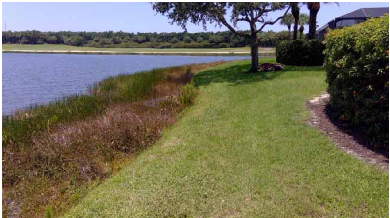
Lake Embankment - 1A
