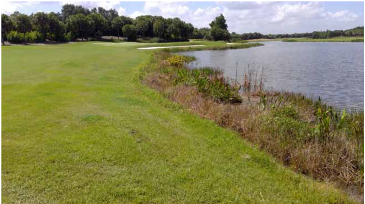
Lake Embankment - 2A
