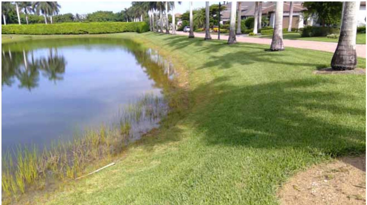
Lake Embankment - 6M
