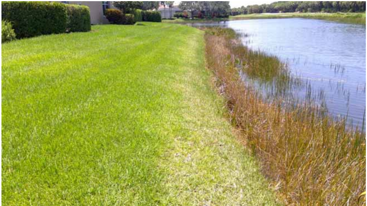
Lake Embankment - 1B
