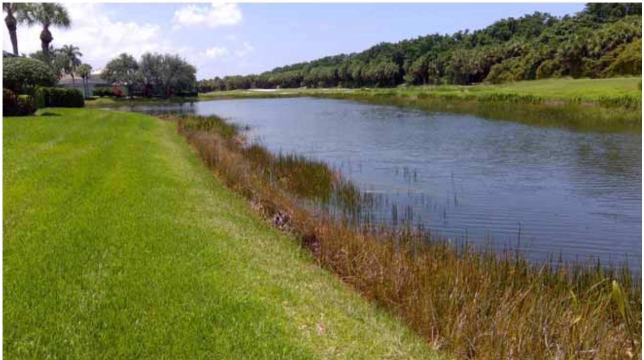
Lake Embankment - 1B
