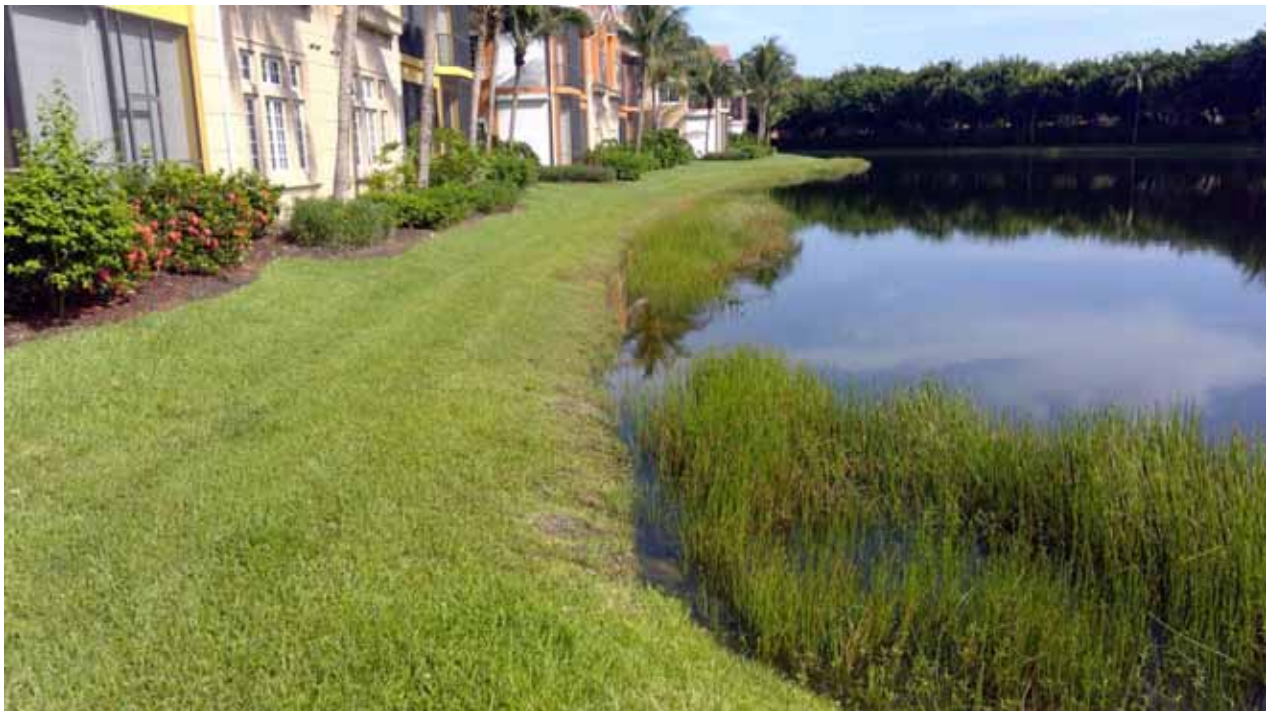
Lake Embankment - 6H
