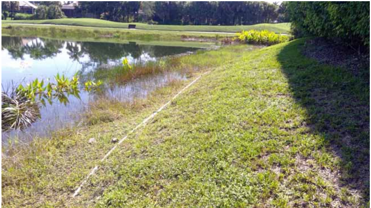
Lake Embankment - 6B
