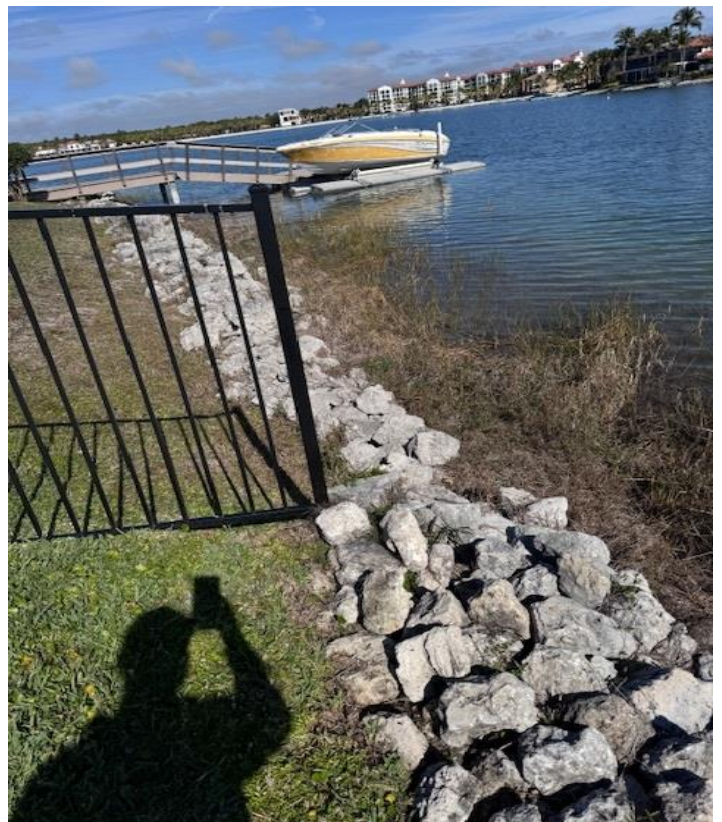
Verna Lago Rip-Rap
