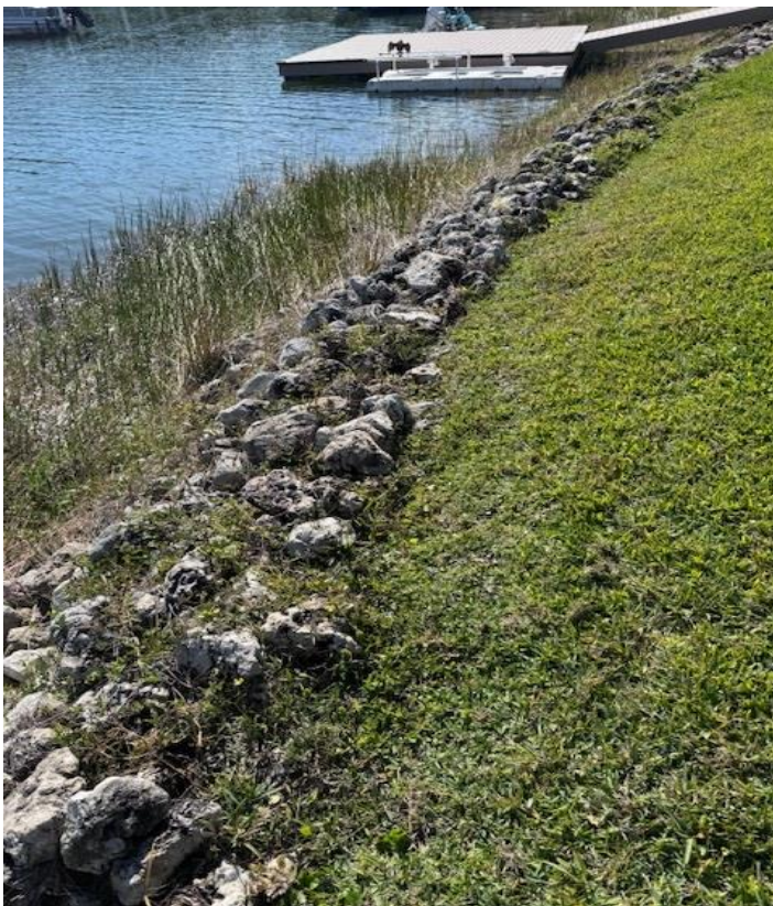
Verna Lago Rip-Rap
