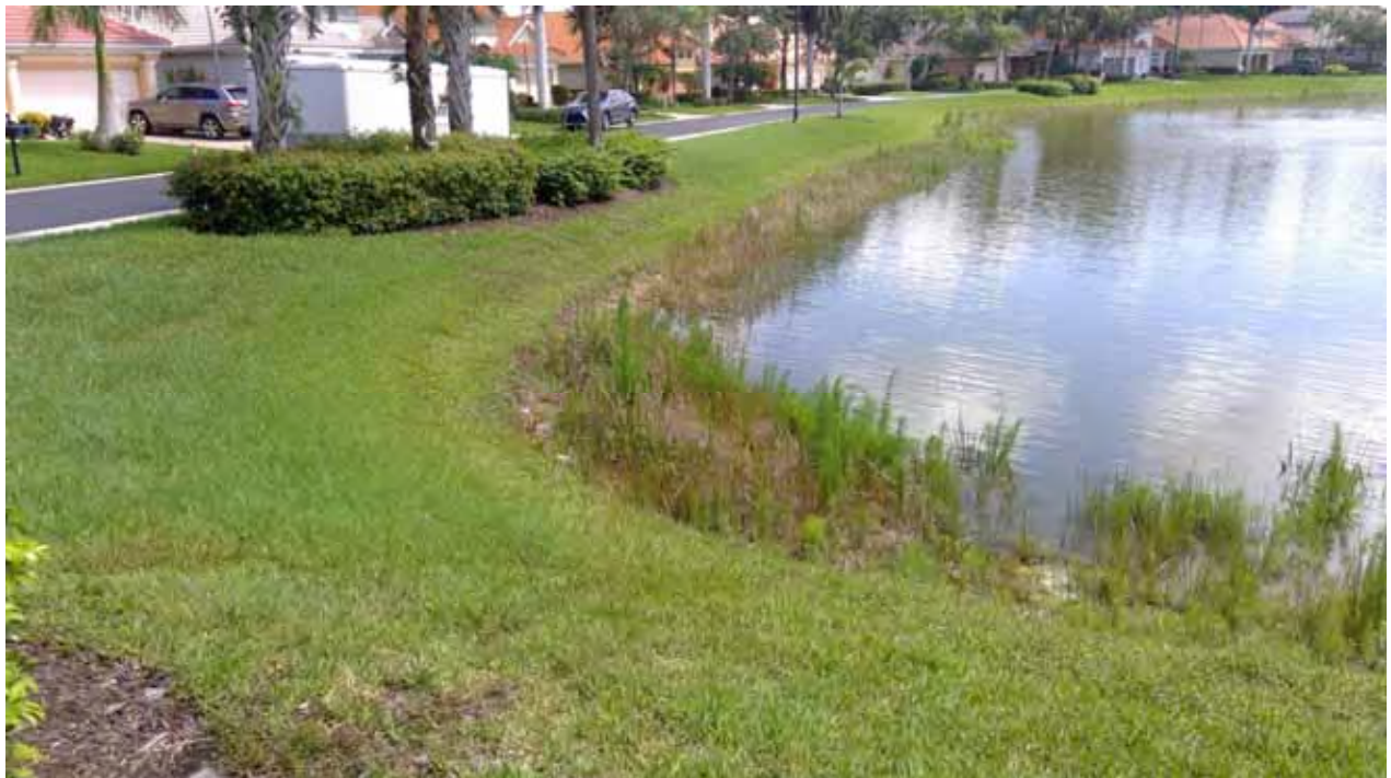
Lake Embankment - 3B
