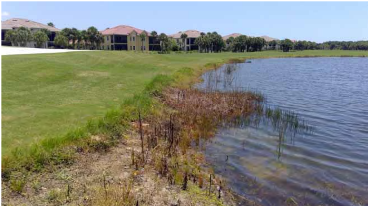
Lake Embankment - 6E
