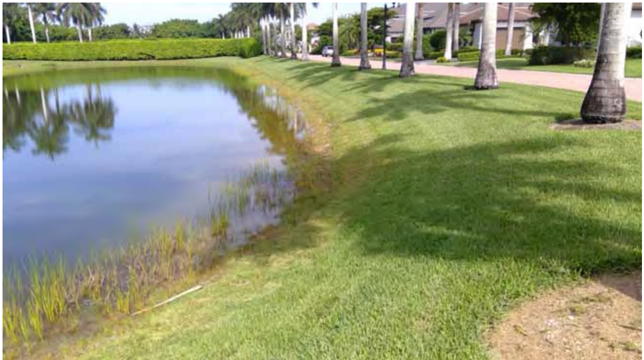
Lake Embankment - 6M
