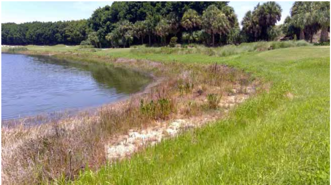
Lake Embankment - 1B
