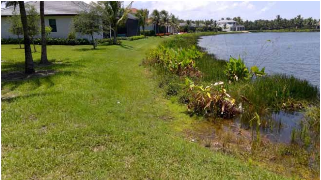
Lake Embankment - 1A
