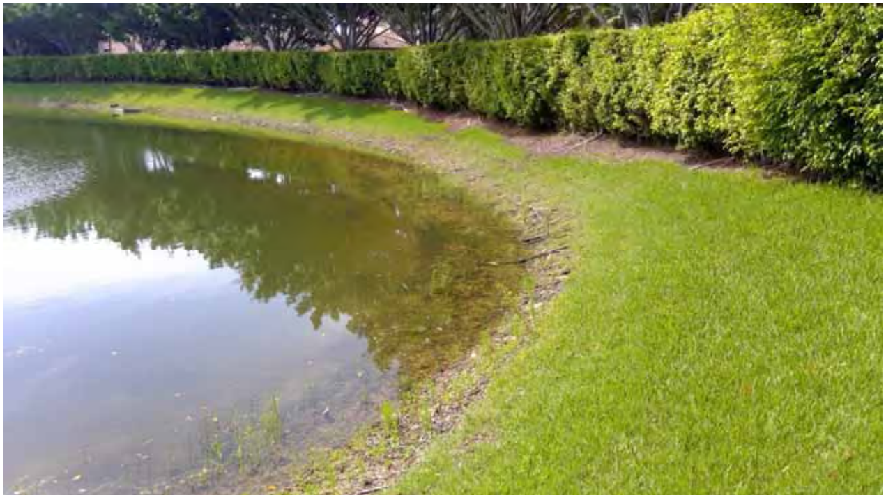
Lake Embankment - 6N
