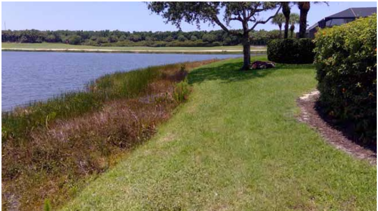
Lake Embankment - 1A
