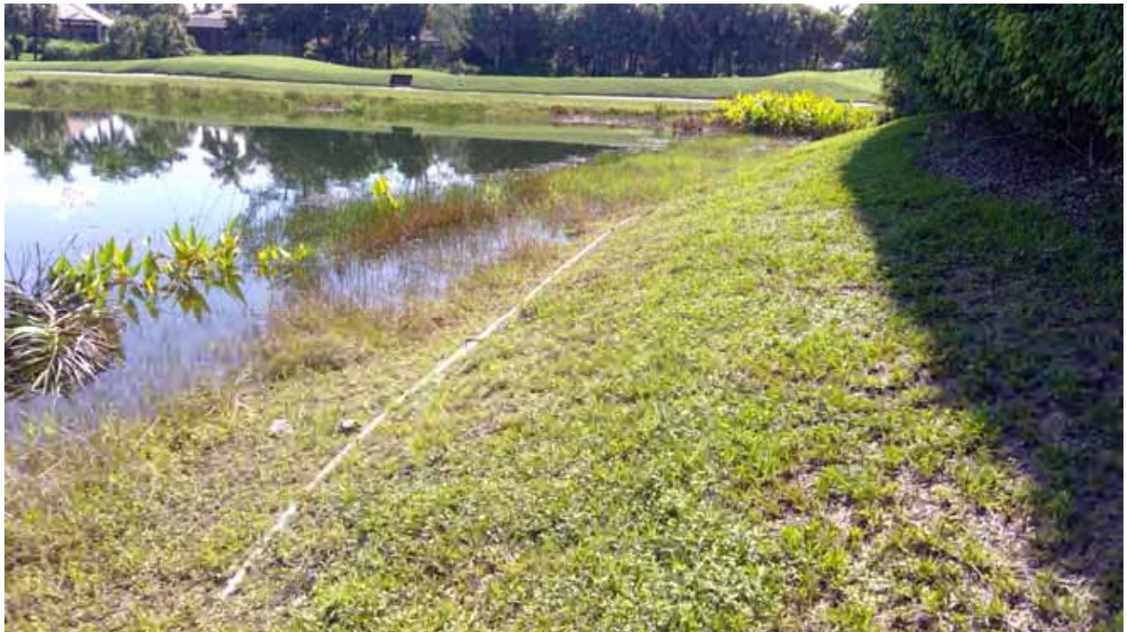
Lake Embankment - 6B
