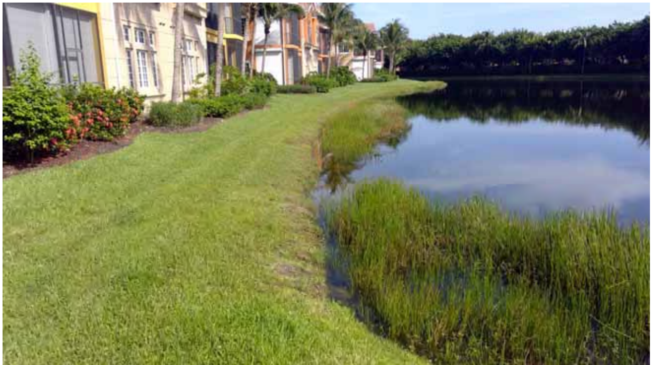
Lake Embankment - 6H
