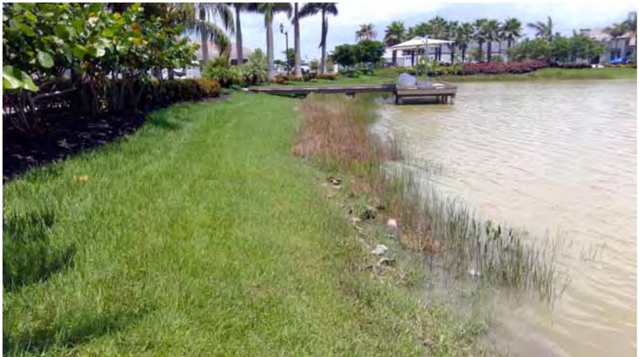
Lake Embankment - Trevi Isle Ln
