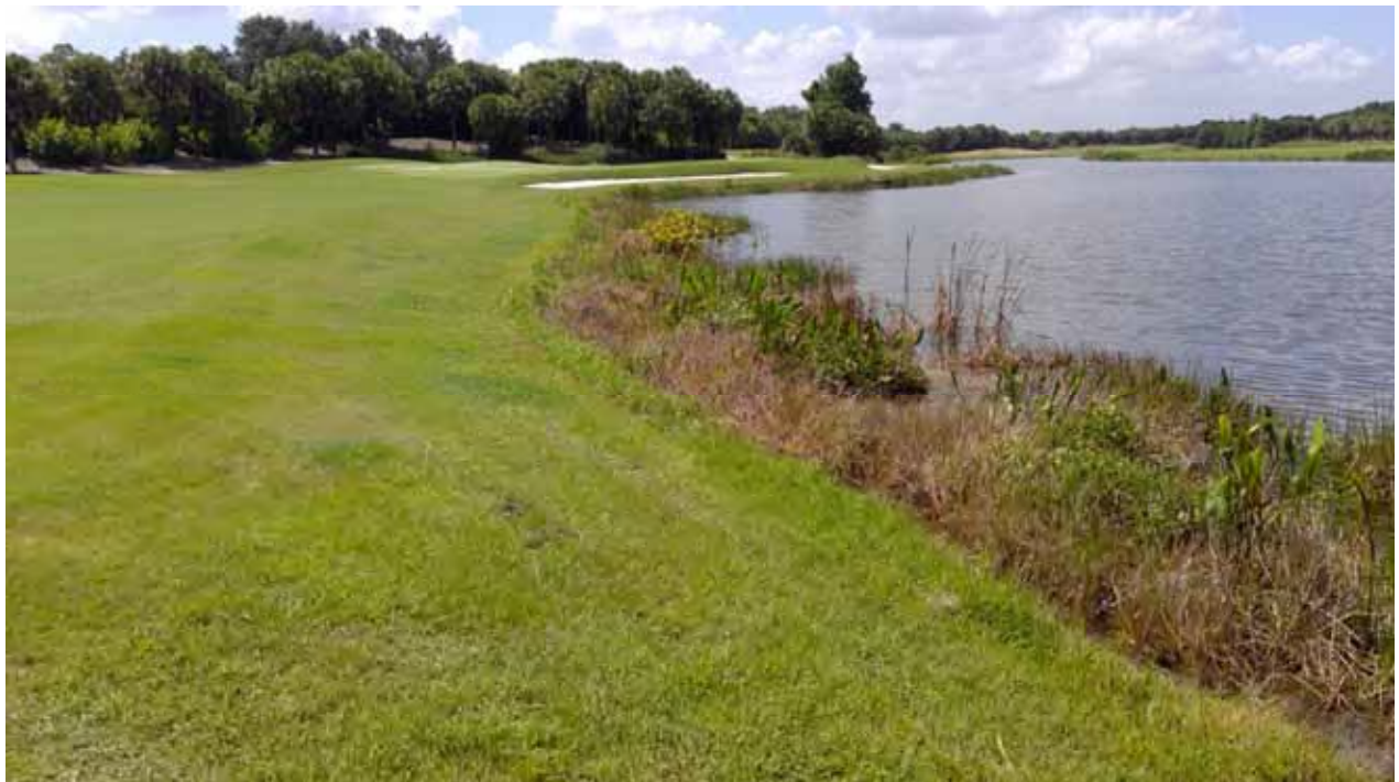
Lake Embankment - 2A
