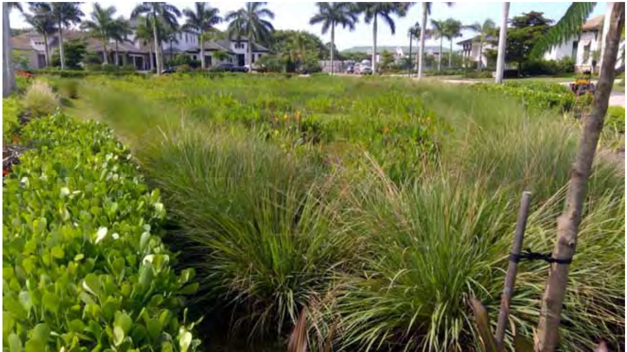
Dry Detention Area - Via Lugano
