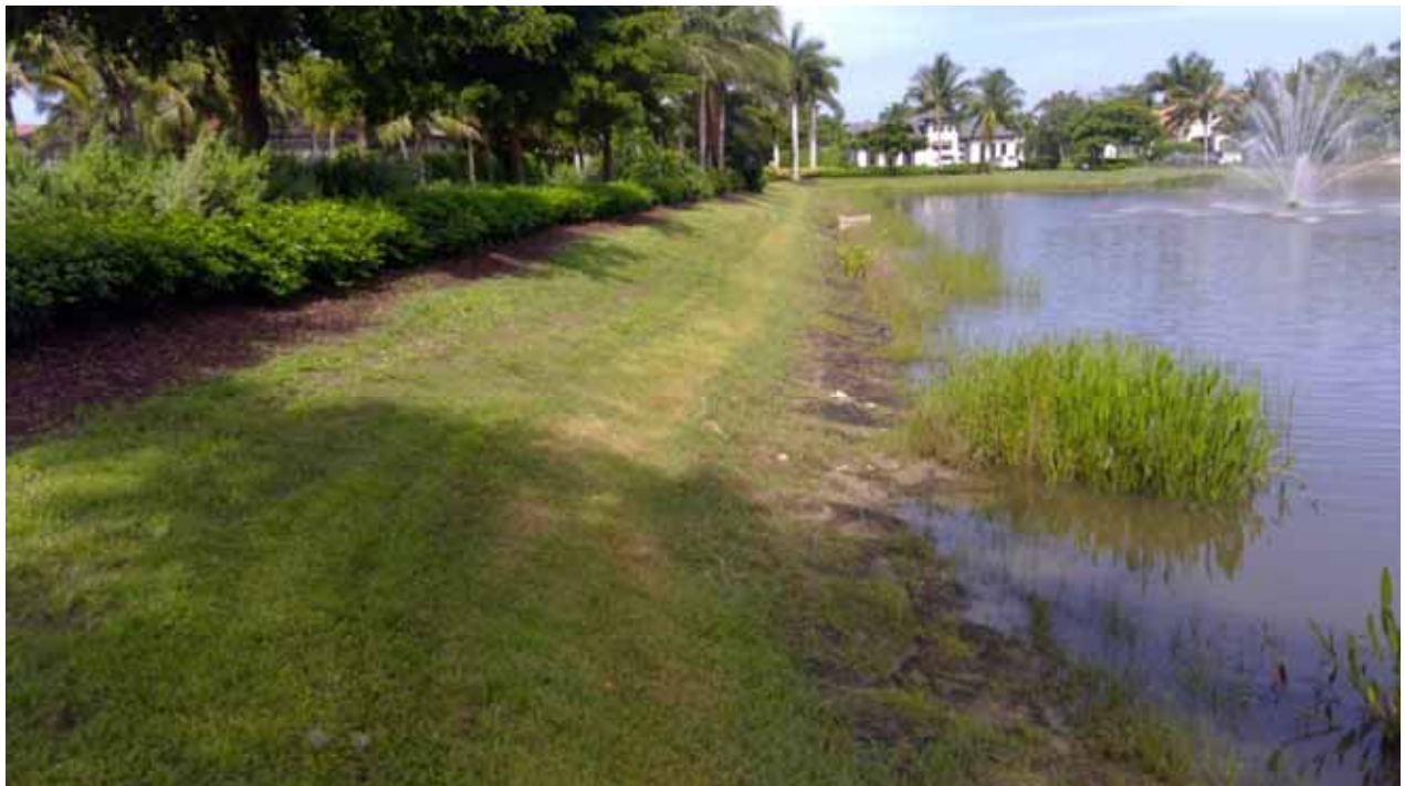
Lake Embankment - 6P
